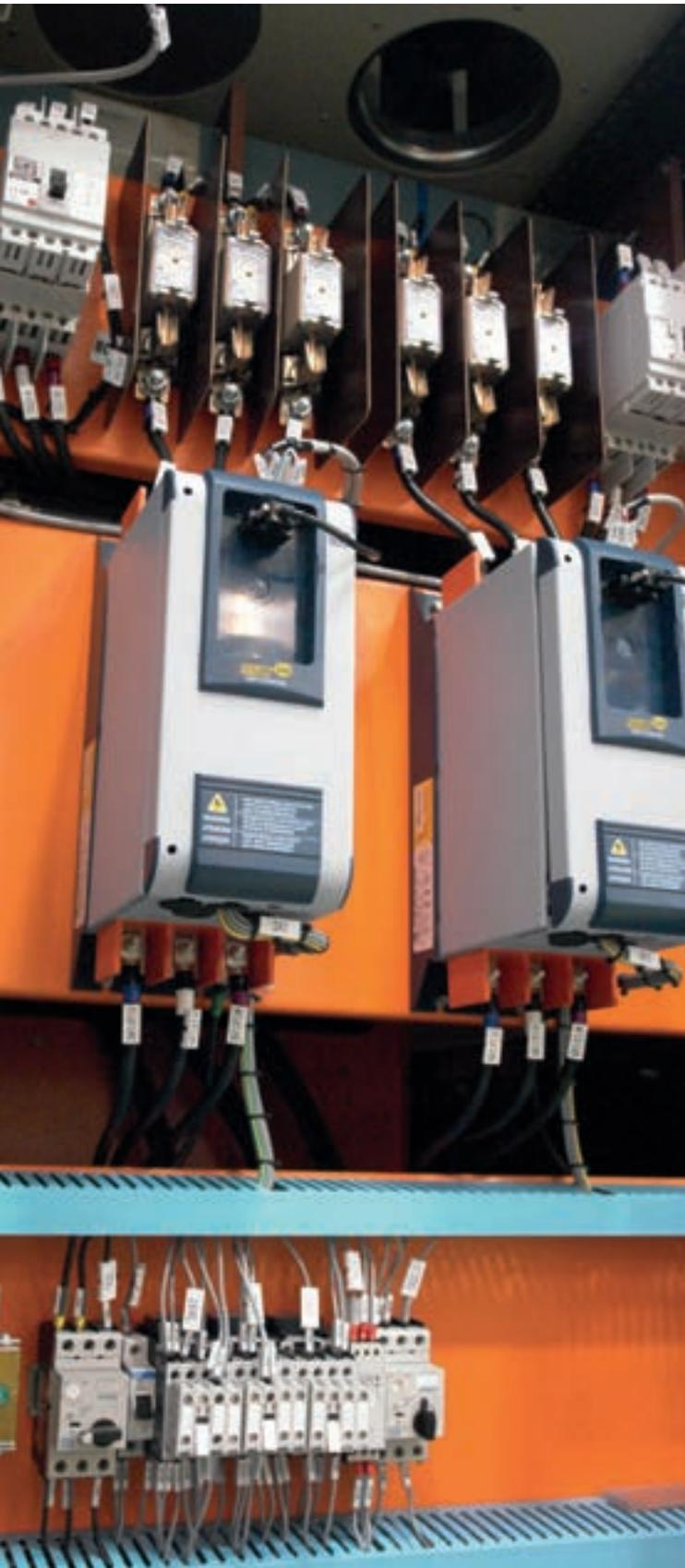
软起动器是一种用于三相异步电机加减速和保护静态起动装置，通过调整晶闸管导通角控制电机电压实现电机平滑起停。适当调整参数后电机可以根据负载情况调整转矩输出，因此所需起动电流降至最低。
